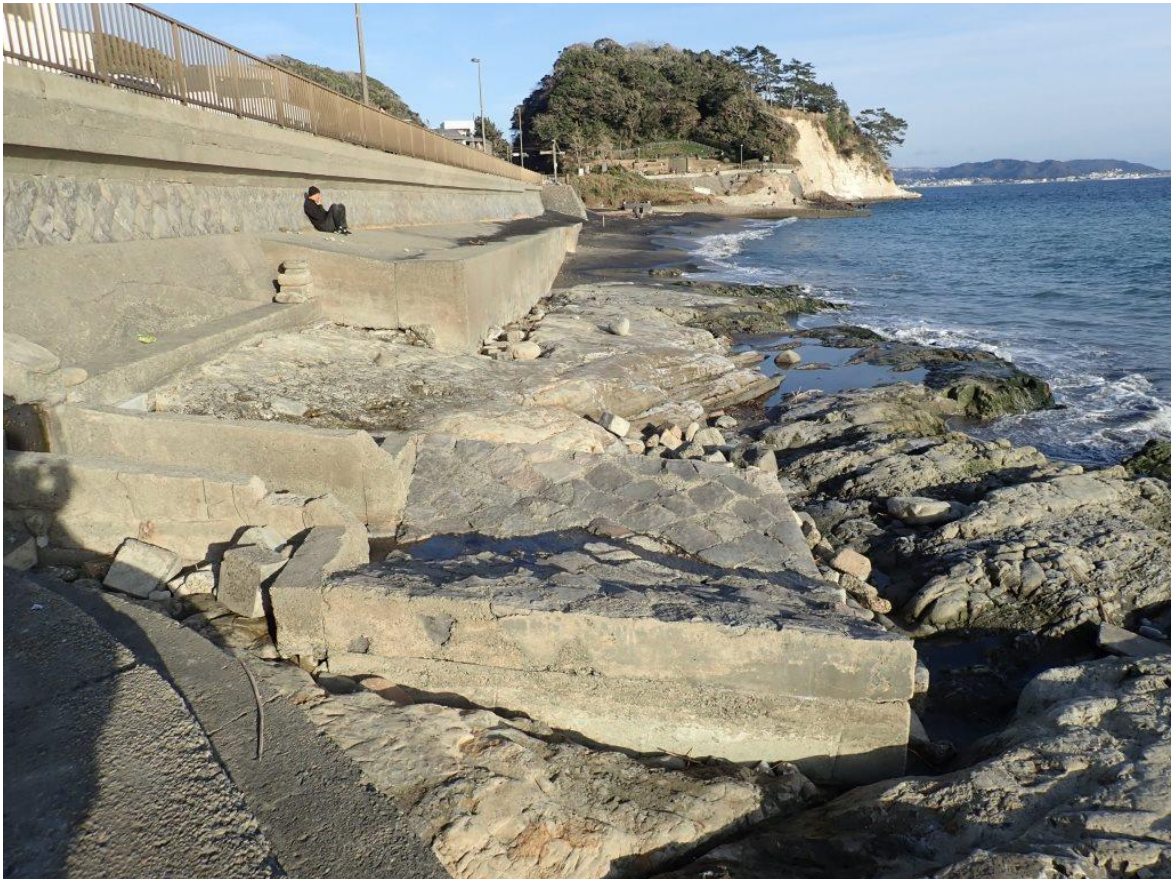
現存する丸階段の下段から撮影。コンクリ基礎の岩着部分に注目！
